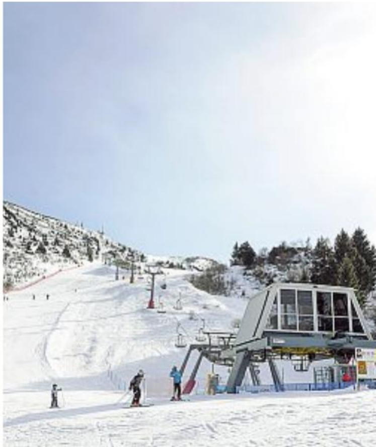
Verso il Palon L'impianto di risalita che porta in vetta
